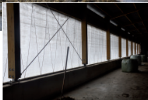
▲► Les auges, délimitées par des rondins de bois (plus de liberté pour les vaches), sont disposées le long des côtés qui sont équipés de rideaux (meilleure aération).
