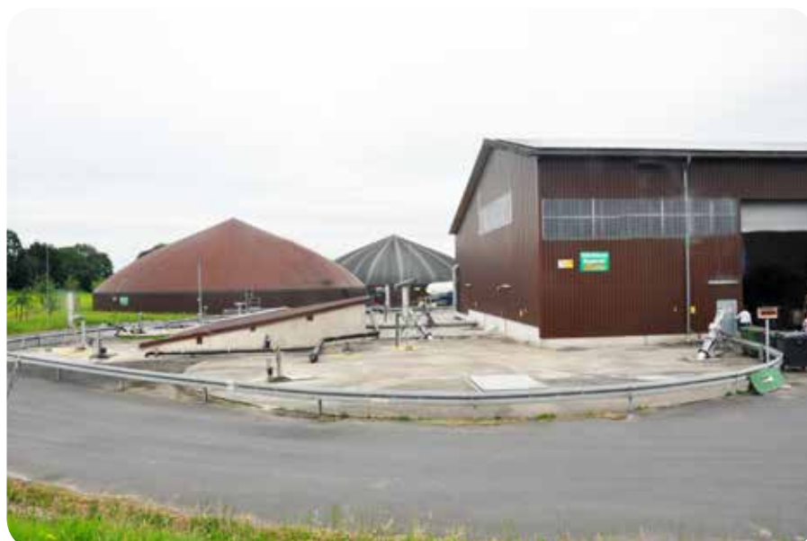
En 2009, l'éleveur a construit, avec un partenaire, une station biométhanisation d'une puissance de 800 KW, un investissement de 4 millions d'euros.
