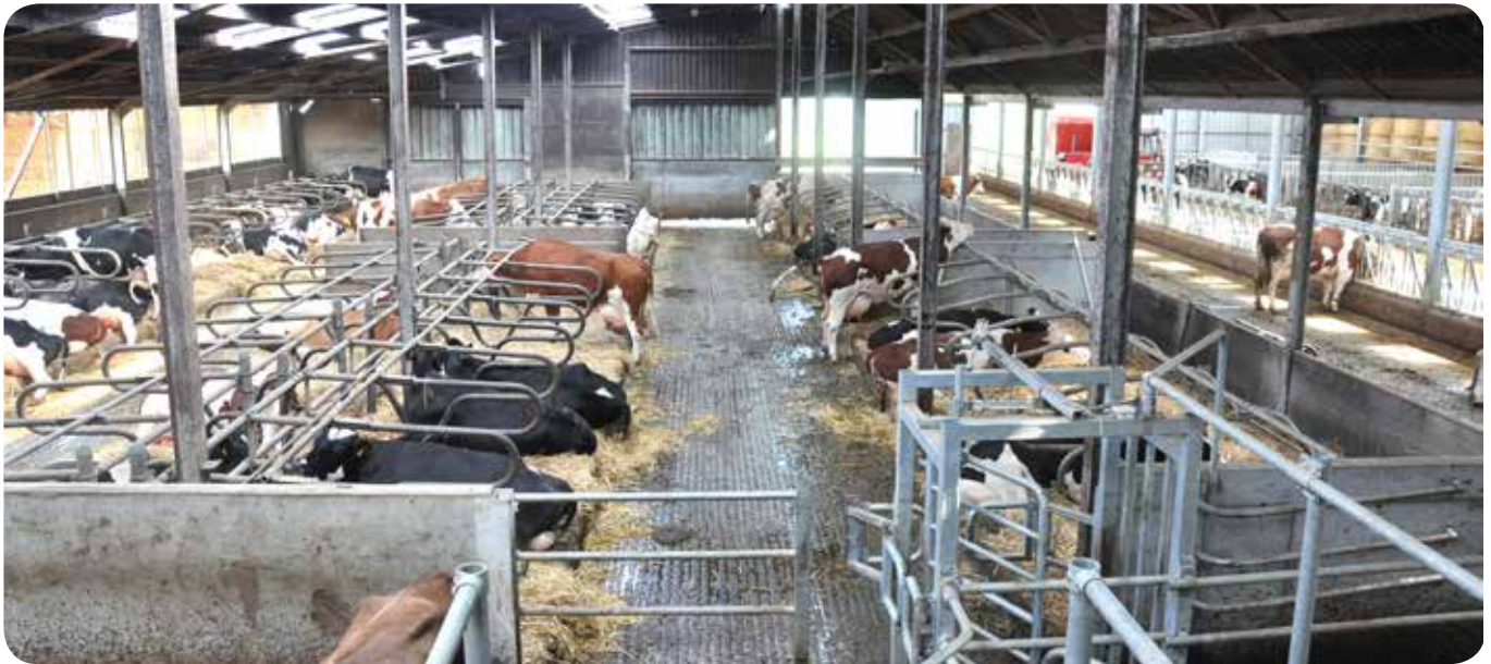
L'étable a été élargie sur la droite par la mise en place d'une quatrième rangée de logettes et d'un couloir d'alimentation latéral sur caillebotis. Une aile destinée au jeune bétail a été construite de l'autre côté de ce couloir.
