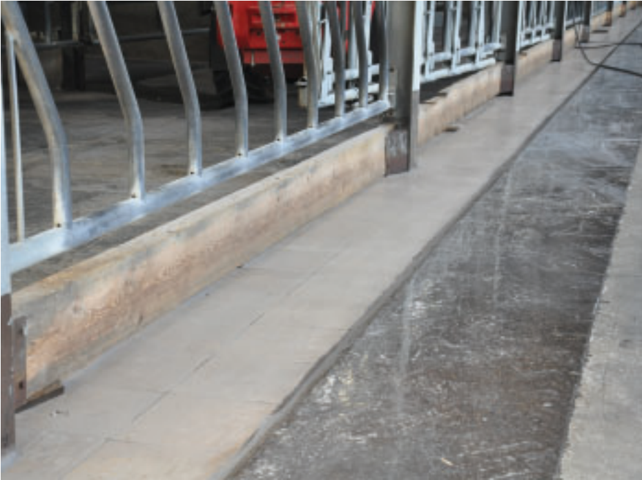
Le fond des auges est carrelé et le béton est recouvert d'époxy.
