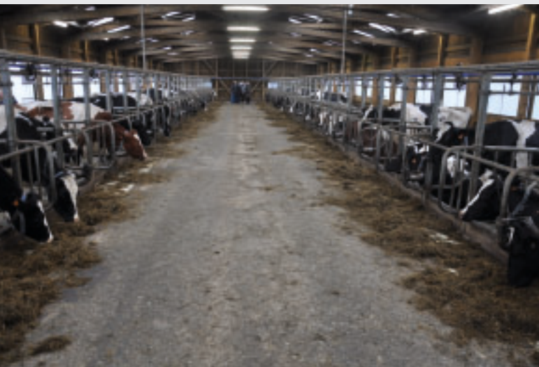
La nouvelle stabulation entravée en bois assure un excellent confort aux animaux et une économie de 30% par rapport à une stabulation libre.
