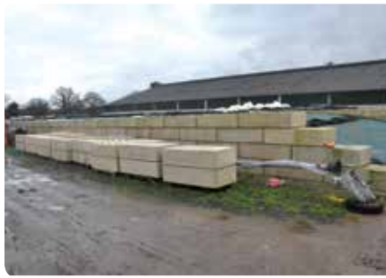
Die Fahrsilos sind durch legobetonsteine konstruiert und können jederzeit angepasst werden.
