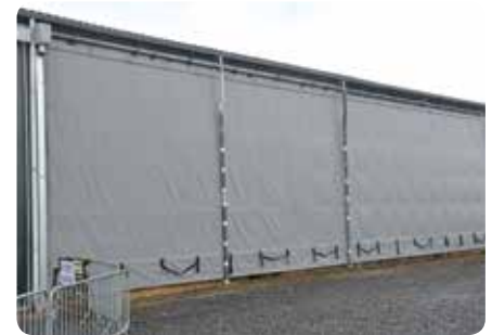
Ein auf Maß geschnittene LKW Plane ( 1800 euro ) dient zur großen Hallentüre
