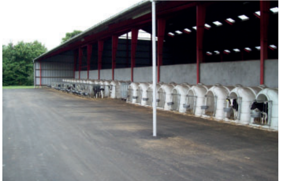
L'hygiène du logement des veaux est très importante
