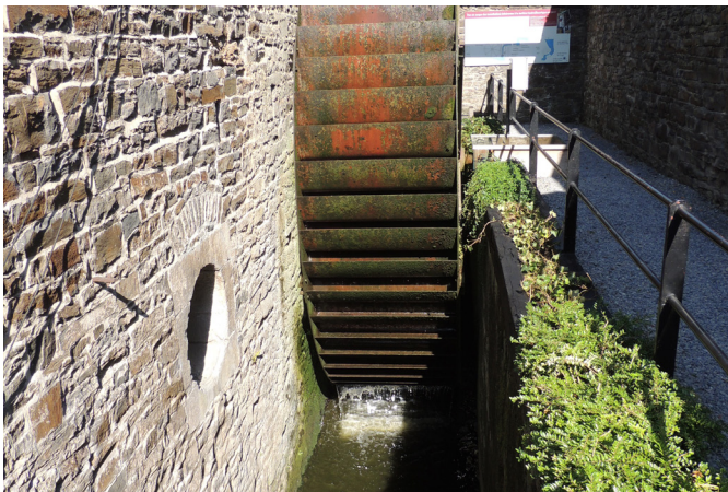
La roue à augets. Au 17 ème siècle, l'eau actionnait deux roues à auges en bois composées de bacs récolteurs appelés augets. Au moment de la révolution industrielle, ces 2 roues ont été remplacées par une seule roue à augets plus importante. Elle compte 56 augets pour un diamètre de plus ou moins 6 mètres. Ils sont remplis via un chenal métallique.
